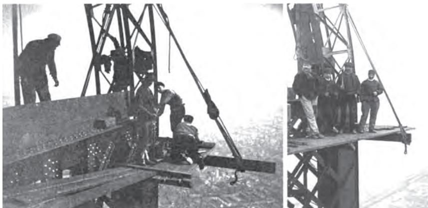
Рис. 1.2. Рабочие моменты монтажа самой верхней части конструкций Эйфелевой башни. Эти рабочие объективнее всех оценивают, насколько точно проведена работа «на земле». 1889 г.
